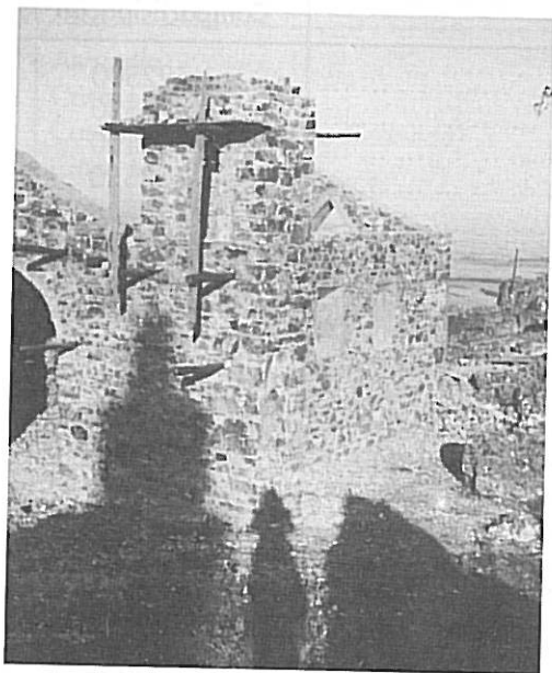
Fase adiantada da construção
